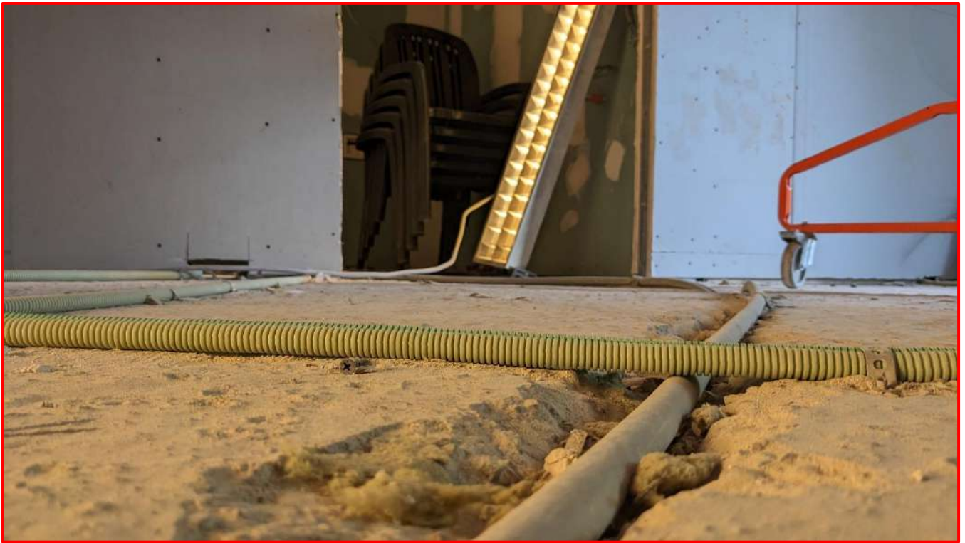
Les travaux vont bon train...
